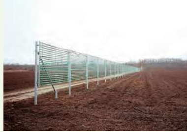
パラウェーブフェンス(網走) ネット高さ2.7m
