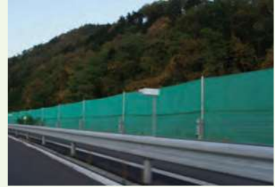
防塵・目隠しネット(夕張) ネット高さ2m
