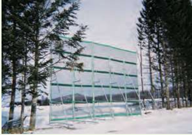
防風林補償防風ネット(幕別) ネット高さ7m
